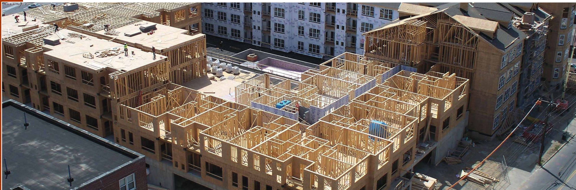
Construction multilogement à ossature légère préfabriquée. Photo : Cecobois
