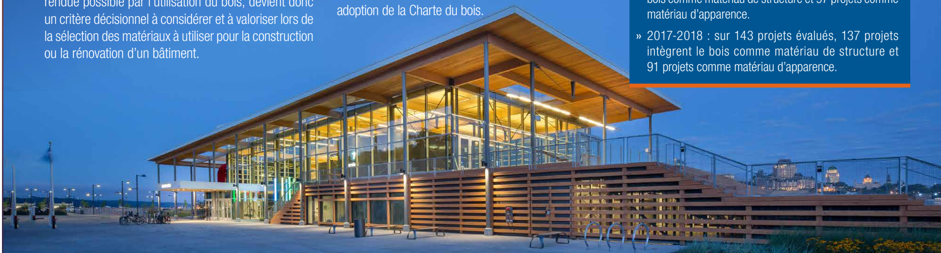
Gare fluviale de Lévis (2014-2015), un bâtiment découlant de l'exemplarité gouvernementale. Photo : Cecobois
